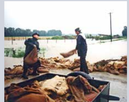
1997: Mit Sandsäcken kann die Vogelsiedlung gesichert werden
