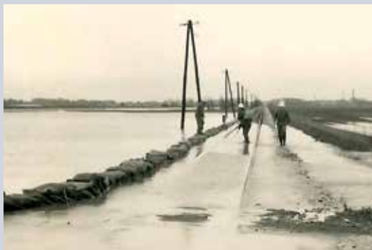
1965: Das Wasser dringt über die Aspangbahn in das Siedlungsgebiet ein.
