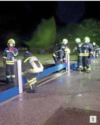
1 Aufbau des Hochwasserschutzes in der Nacht
