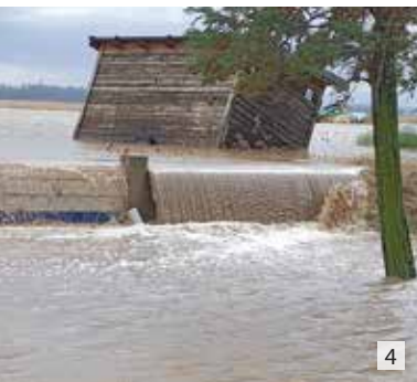
4 + 5 Der Hochwasserschutz beim Lagerhaus wird massiv überströmt
