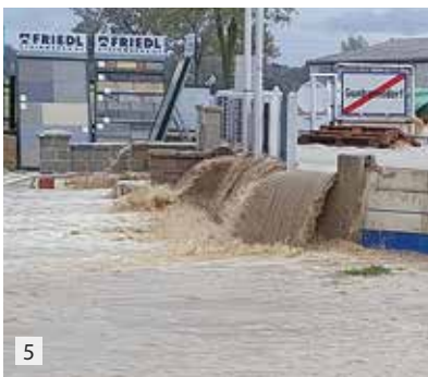
4 + 5 Der Hochwasserschutz beim Lagerhaus wird massiv überströmt
